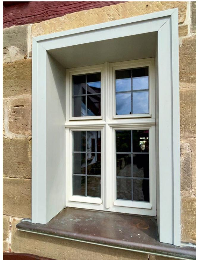
Kombination SCHOTT GOETHEGLAS und Schallschutzverglasung SSK4, Holzart Lärche
