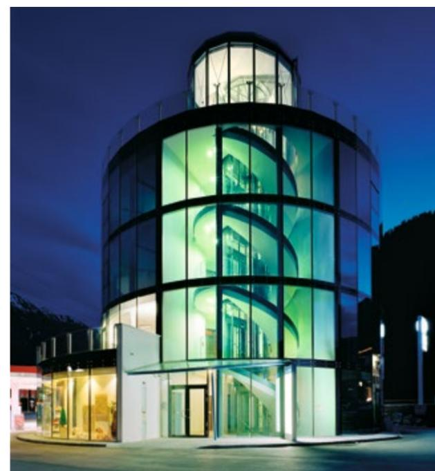
Pour la Bluetower à St.-Johann, l'architecte a réalisé une façade en verre agrafé résistant au feu SCHOTT. La liaison entre les panneaux de verre isolants et PYRAN® S a été réalisée essentiellement par des profils conçus spécialement pour ce projet et fixés par des supports en acier inoxydable au niveau des plafonds.
