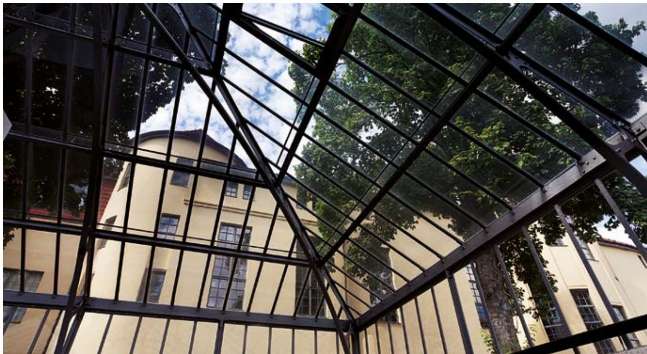
Bauhaus-Universität Weimar – Brendelsches Atelier mit SCHOTT RESTOVER® als Verbundglas
