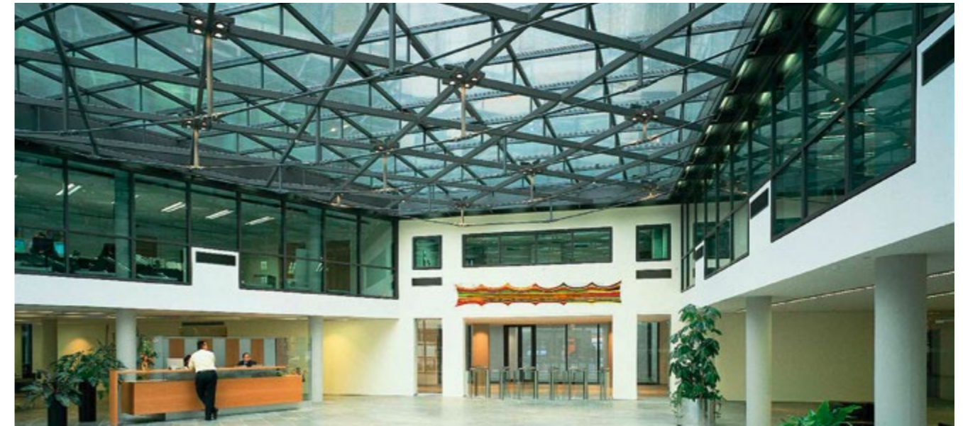
Westdeutsche Immobilienbank in Mainz, Brandschutzdach G30 ausgeführt von Fa Krause PYRAN® S Spezialglas von SCHOTT.
