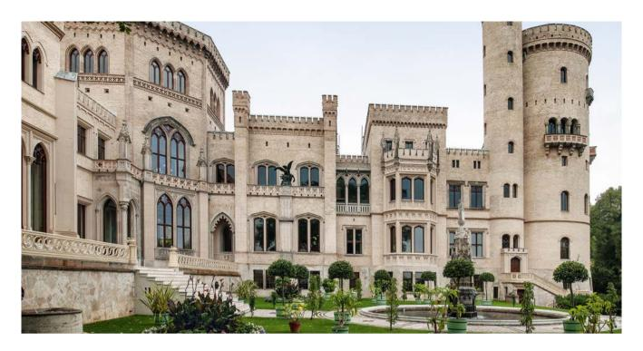
Großteil der Ganzglasfenster ausstatten. Die 4,5 Meter hohen Sonderformate im Hauptgeschoss des Schlosses wurden als Verbundglas mit Stoßfuge ausgeführt. Zudem wurden für speziell genutzte Räume aus klimatischen Gründen Isoliergläser mit einer Außenscheibe aus GOETHEGLAS und einer Innenscheibe aus Floatglas hergestellt.
