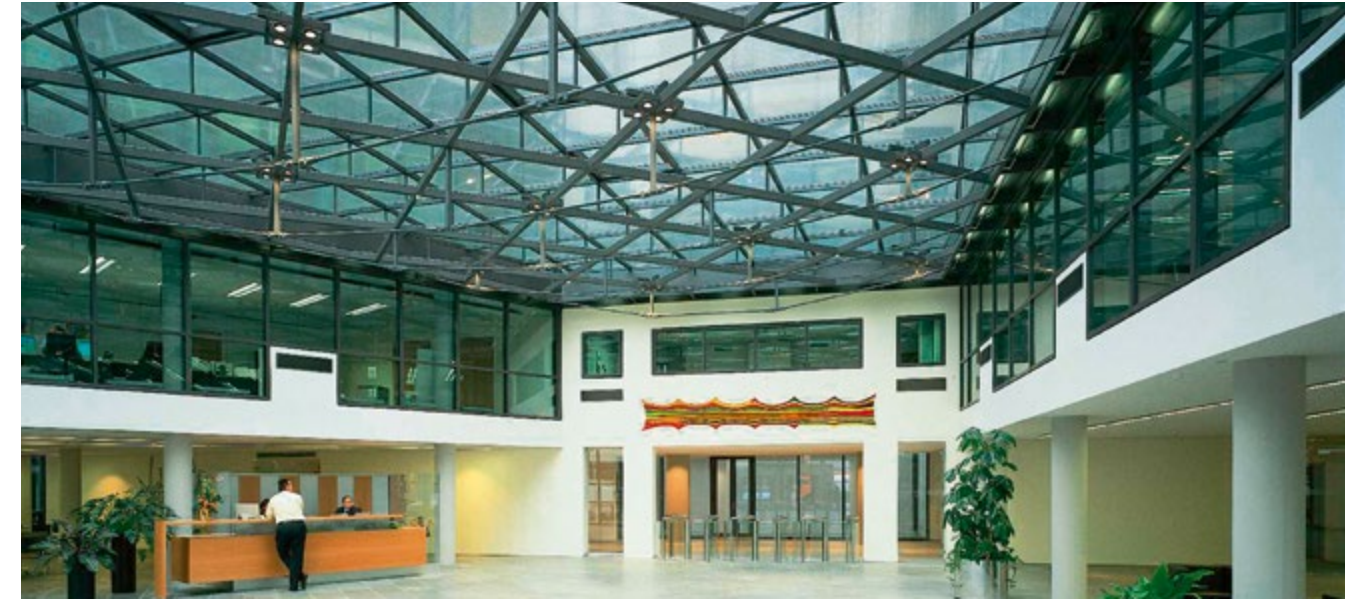
Westdeutsche Immobilienbank en Mainz, cubierta de protección contra incendios E 30 realizada por la empresa Krause Vidrio especial PYRAN® S de SCHOTT.
